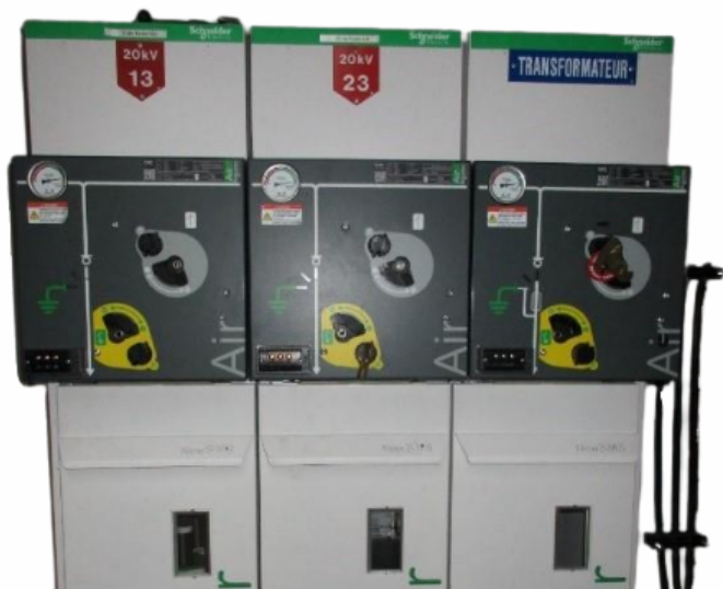
Nouvelles cellules SM Air SET (sans SF6)
